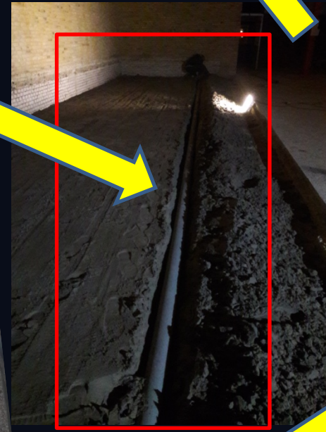
Buizen voor bedrading
